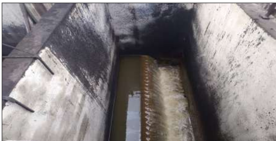
الشكل (٣) صورة مصب مياه الصناعية بعد معالجتها في مصفاة بانياس.
