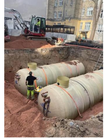
(ج) أحواض تجميع مياه الأمطار تحت الفناء. (د) تجديد الواجهة المطلة على الفناء لتعزيز الطاقة
