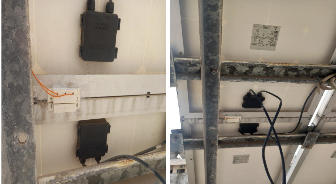
الشكل (١٥): توضع الحساس MC-38 على اللوح الشمسي الموجود على سطح كلية الهندسة التقنية الجدول (١) يوضح حالات عمل الحساس
