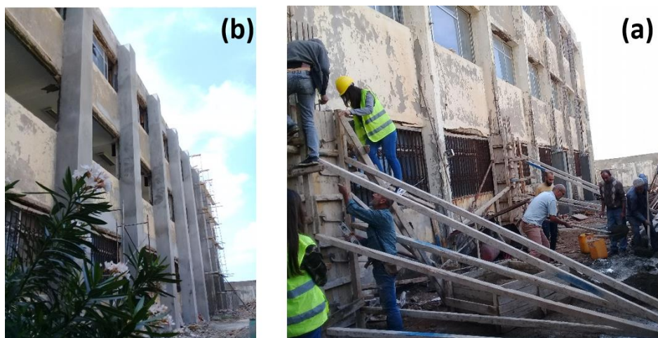
الشكل (١٦): (a) عملية كفرجة قمصان الأعمدة للطابق الأرضي وصيها، (b) شكل الأعمدة في الجهة الشمالية من المبنى بعد الانتهاء من تدعيمها بقمصان بيتونية مسلحة وتطينها بمونة اسمنتية.
