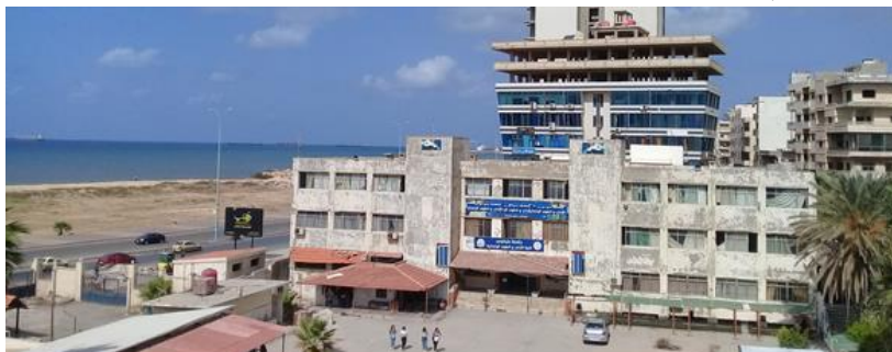
الشكل (٢١): شكل مبنى كلية الآداب بجامعة طرطوس قبل إجراء عملية التدعيم (واجهة جنوبية) ويلاحظ قريتها من البحر.
