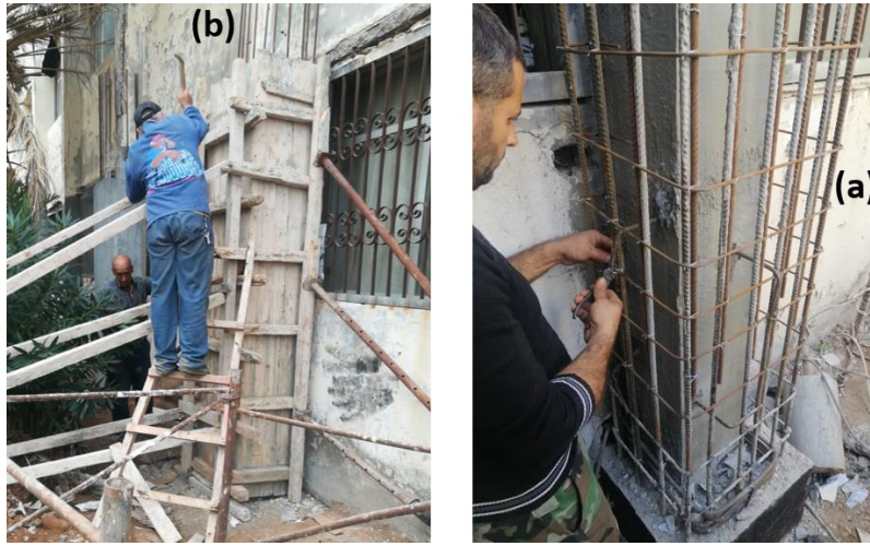
الشكل (١٤): (a) تثبيت هيكل التسليح للقمصان الجديدة للطابق الأرضي ودهن سطح بيتون الأعمدة القديمة بمادة SBR لزيادة التلاحم بين البيتون القديم والبيتون الجديد، (b) عملية كفرجة قمصان الأعمدة وصبها.
