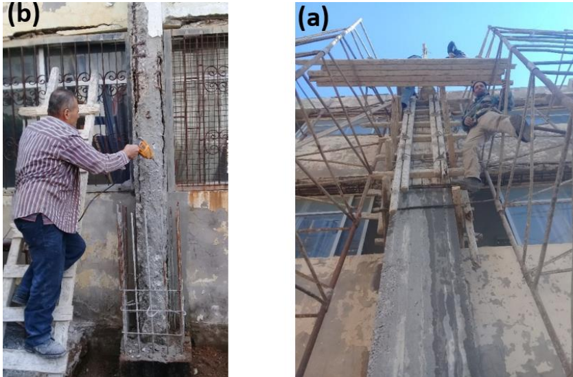
الشكل (١٥): (a) عملية كفرجة قمصان الأعمدة للطوابق العليا وصبها، (b) إزالة البيتون المتشقق من الأعمدة القديمة ودهنها بـ SBR وتنظيف قضبان التسليح القديمة من الصدأ ودهنها بالإبوكسي.
