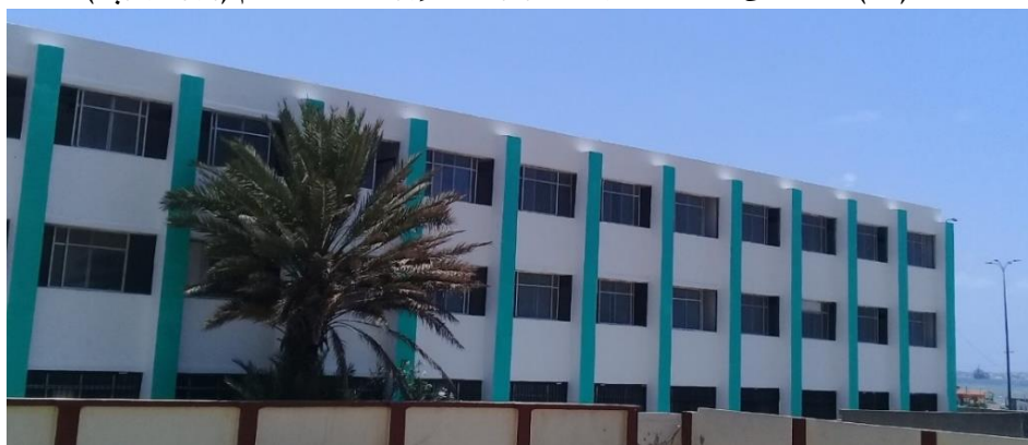
الشكل (٢٣): شكل مبنى كلية الآداب بجامعة طرطوس بعد إجراء عملية التدعيم (واجهة شمالية).
